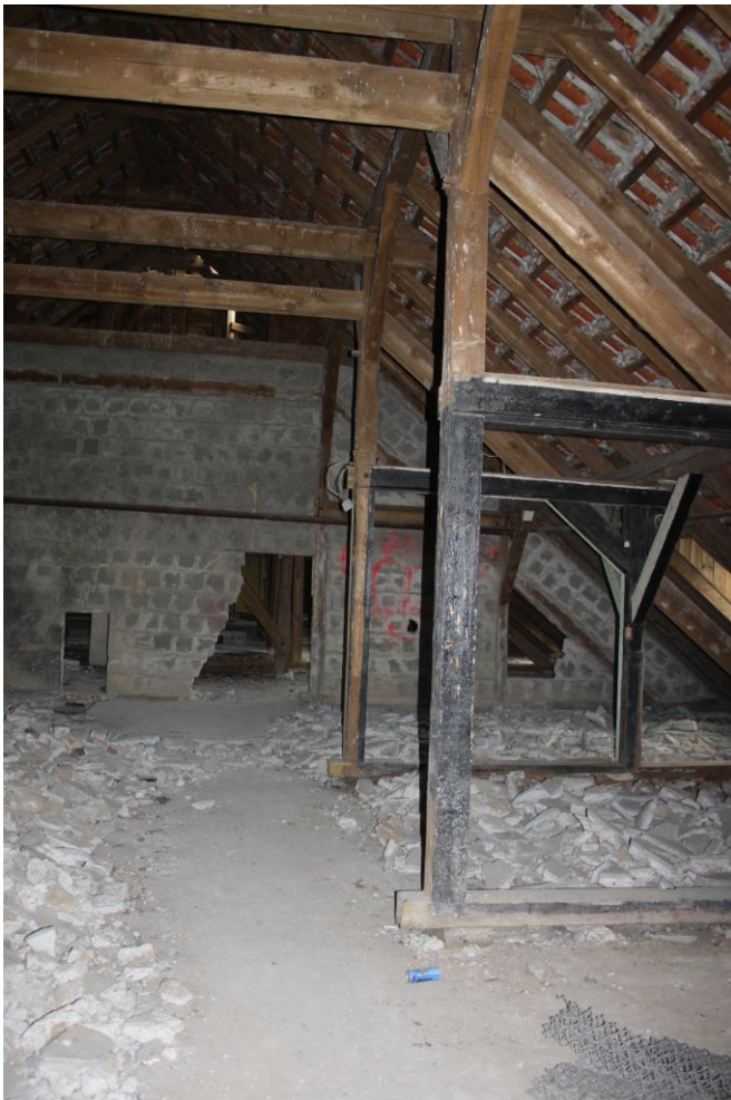
Abbildung 3-1: Der Dachboden des Gebäudes
